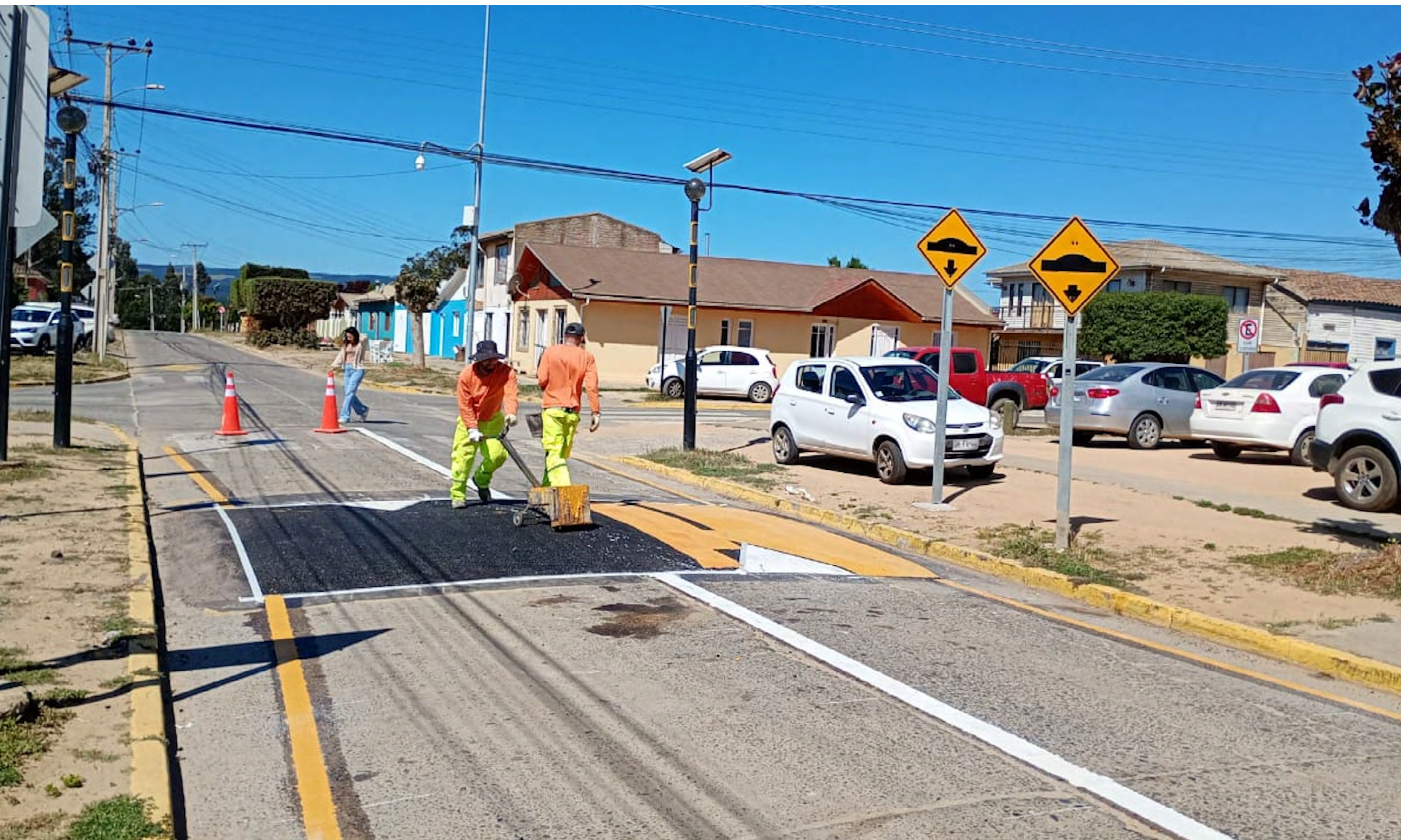
Adquisición e instalación de balizas y bandas alertadoras en cruces peatonales
