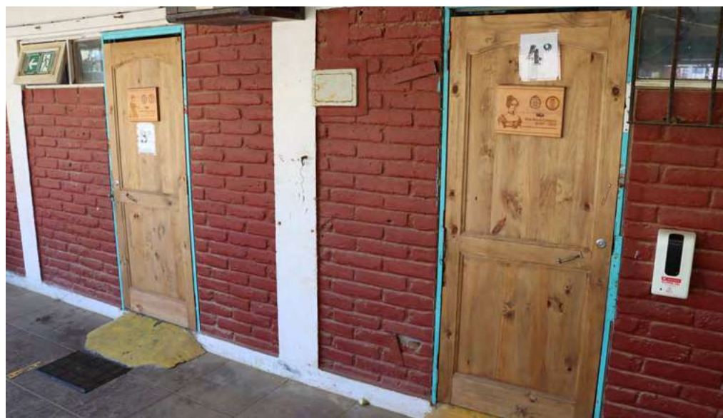
Recambio puertas y canaletas $1.635.980 (Municipio).
