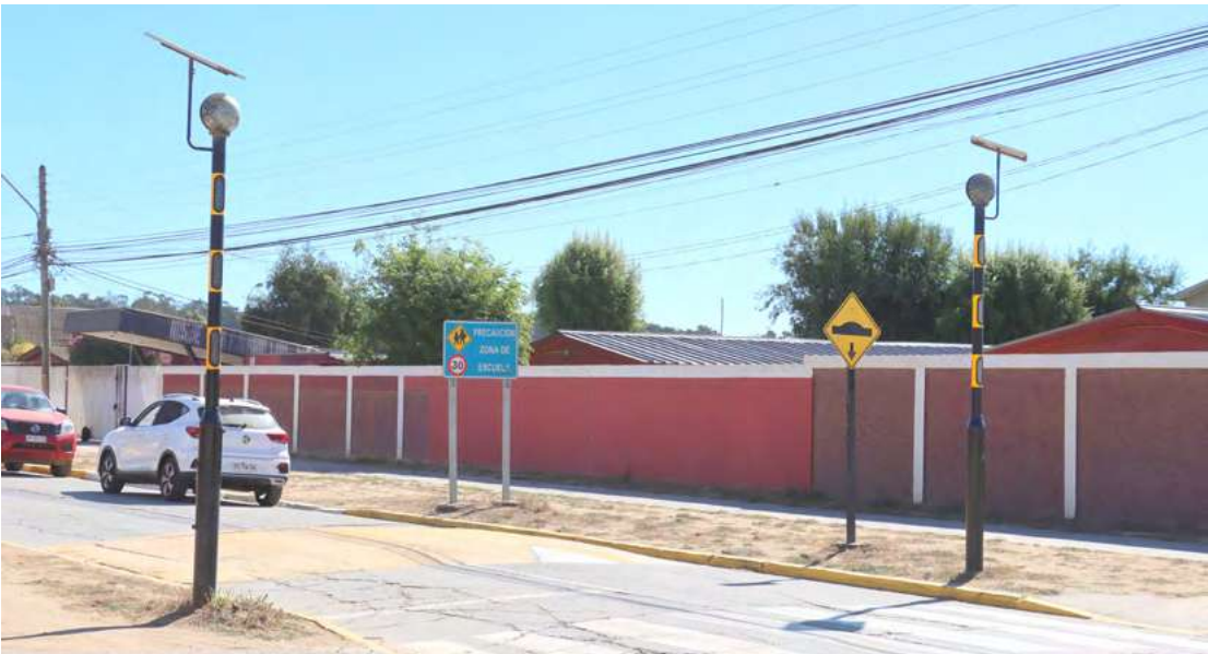
Adquisición e instalación de balizas y bandas alertadoras en cruces peatonales
