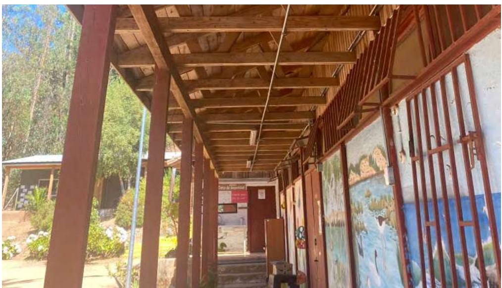
Mejoramiento red eléctrica – $25.692.978 (MINEDUC).
