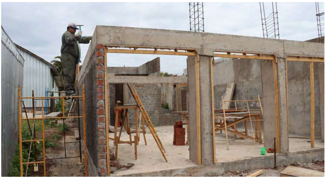
Construcción sede Junta de Vecinos Infiernillo
