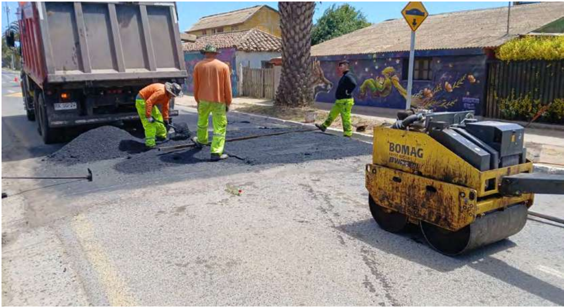
Demolición y regularización de resaltos reductores de velocidad
