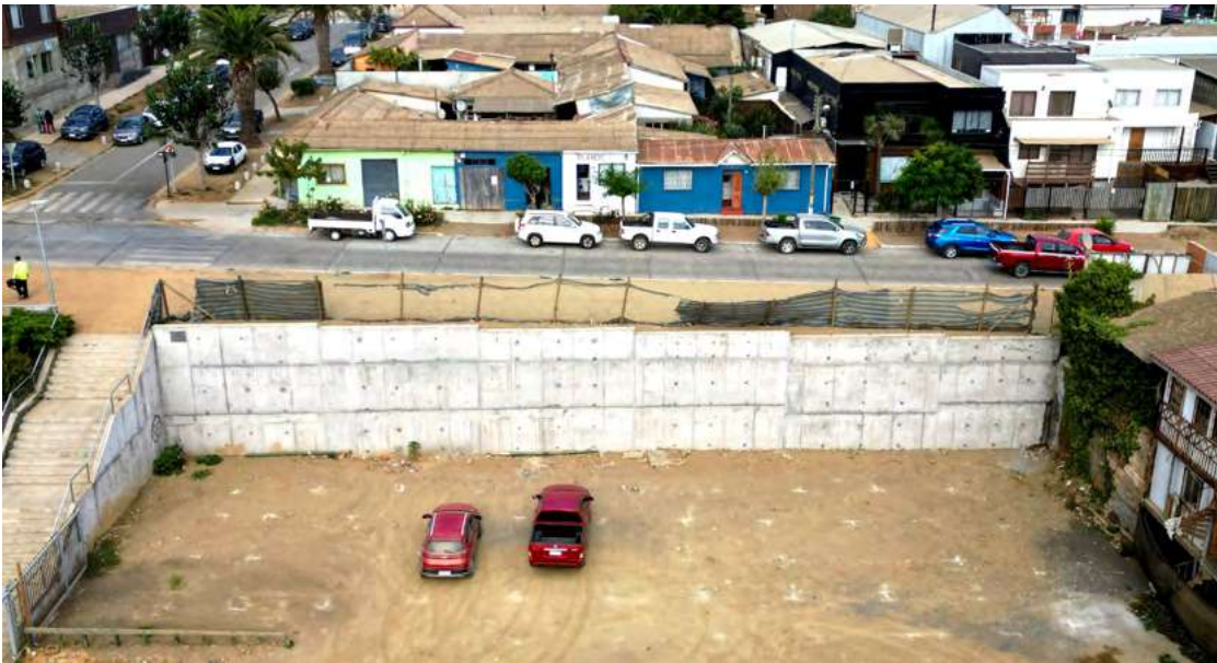
Construcción muro de contención en calle J.J. Aguirre
