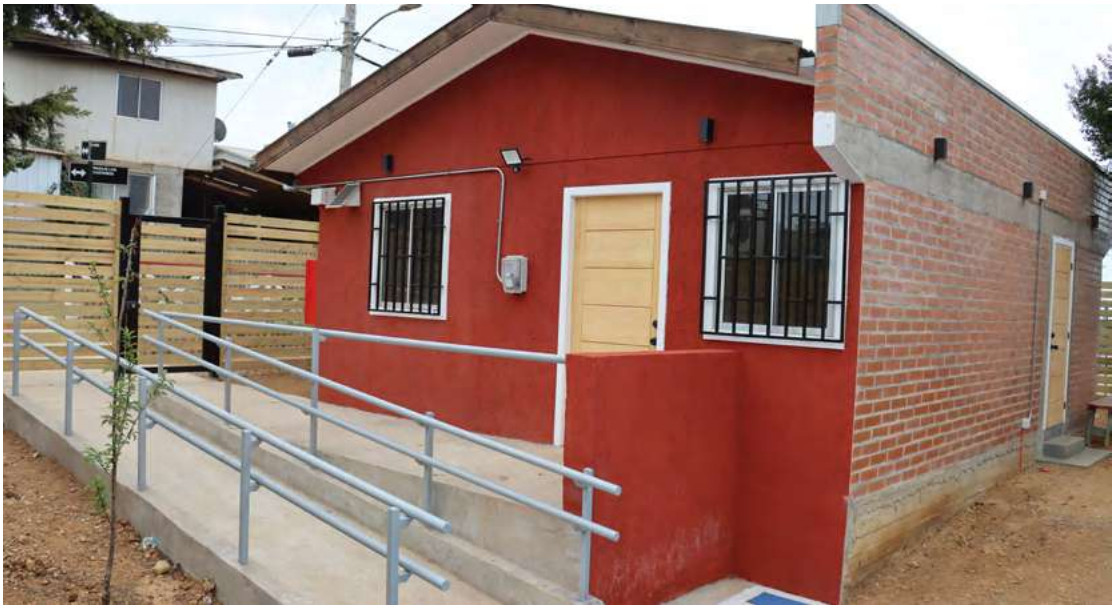
Ampliación y mejoramiento de la sede Villa Atardecer
