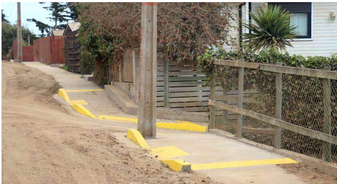
Construcción de veredas en Población Los Mineros
